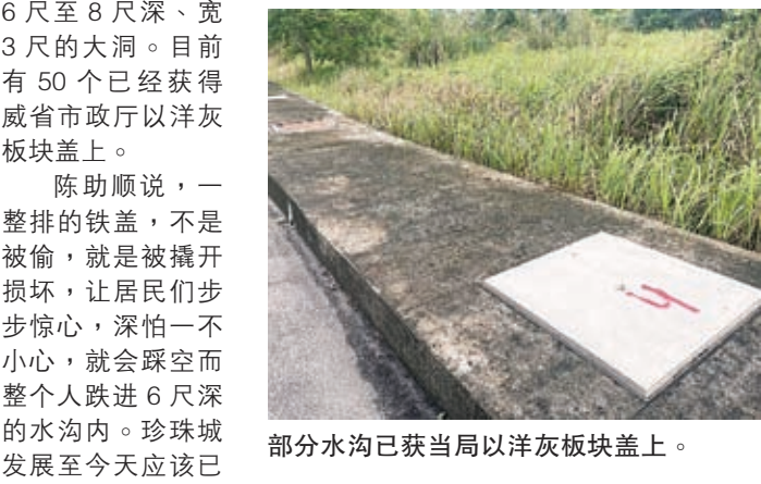
部分水沟已获当局以洋灰板块盖上。
