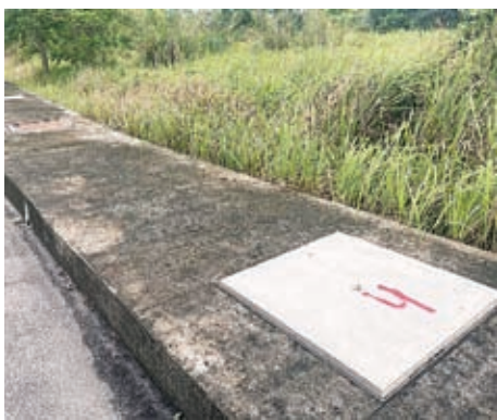
部分水沟已获当局以洋灰板块盖上。
