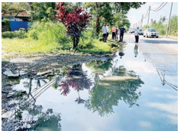
甘榜勿刹地下排水管道阻塞导致积水数月,武拉必州议员王丽丽要求工程局尽快解决问题。
